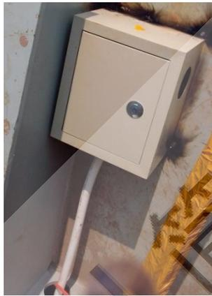
图 3. 铝塑管和光纤保护盒对光纤和端头的保护（浇筑前）
