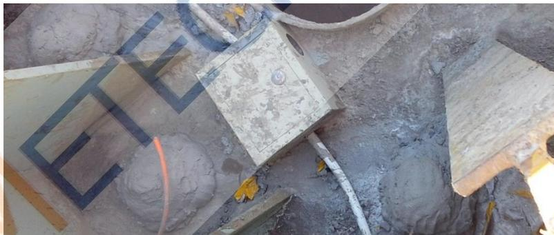
图 4. 铝塑管和光纤保护盒对光纤和端头的保护（浇筑后）
