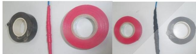
图 6. 接头部位电工胶布包裹图接头部位防水胶布包裹
