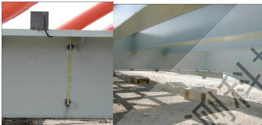
图 2.31 光缆走线及桥两端的安放柜 图 2.32 刚性系杆到横梁处的光缆走线
