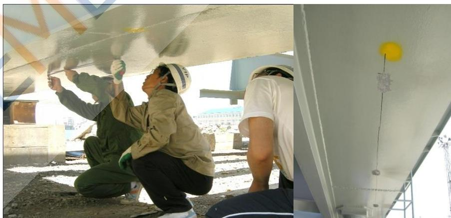
图 2.26 现场确定传感器的安装位置及镀锌管焊接位置
