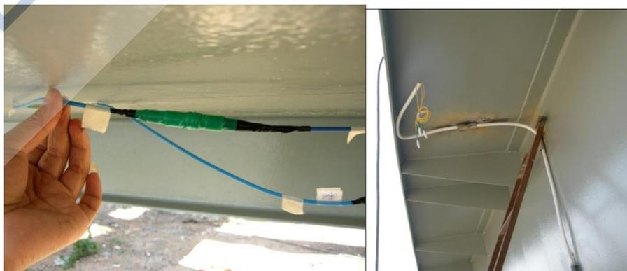
图 2.29 用防水胶布保护的传感器与光缆接头 图 2.30 已安装完成的光缆
