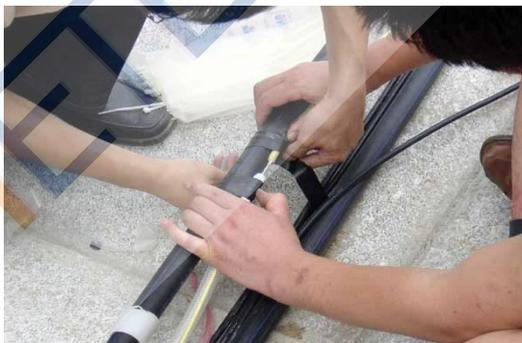
图 8.3 光纤光栅温度传感器现场安装图
